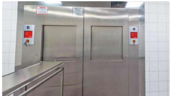
**Паровые стерилизаторы PHS-400 проходного типа в составе ЦСО (вид со стороны чистой и стерильной зоны)**
